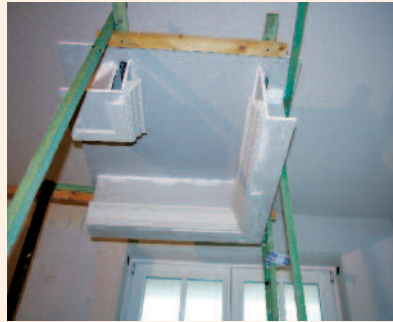
4 Das Deckenfeld über dem Schwimmbad wurde in mehreren Varianten bemustert.
