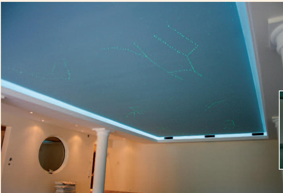
1 Fast 2000 Glasfaserkabelenden bilden sechs Tierkreiszeichen in der Decke des privaten Schwimmbades.
