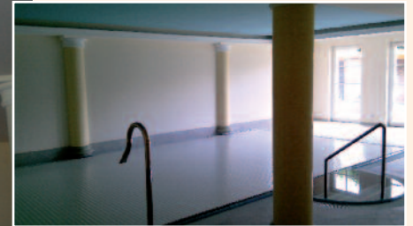
2 Das private Schwimmbad nach der Fertigstellung.
