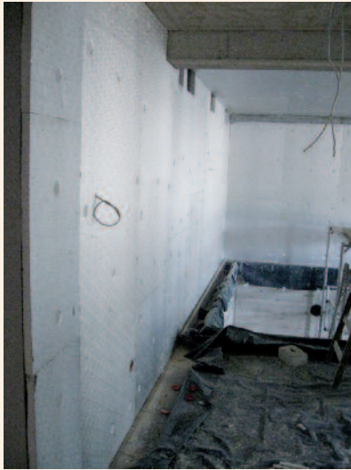
3 Die Innendämmung wirkt als Wärme- und Feuchteschutz.
